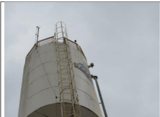
Autor: AMAE Descrição: REL Campestre escada tipo marinheiro, guarda corpo, cabos de aterramento para-raios e sinalização noturna.
